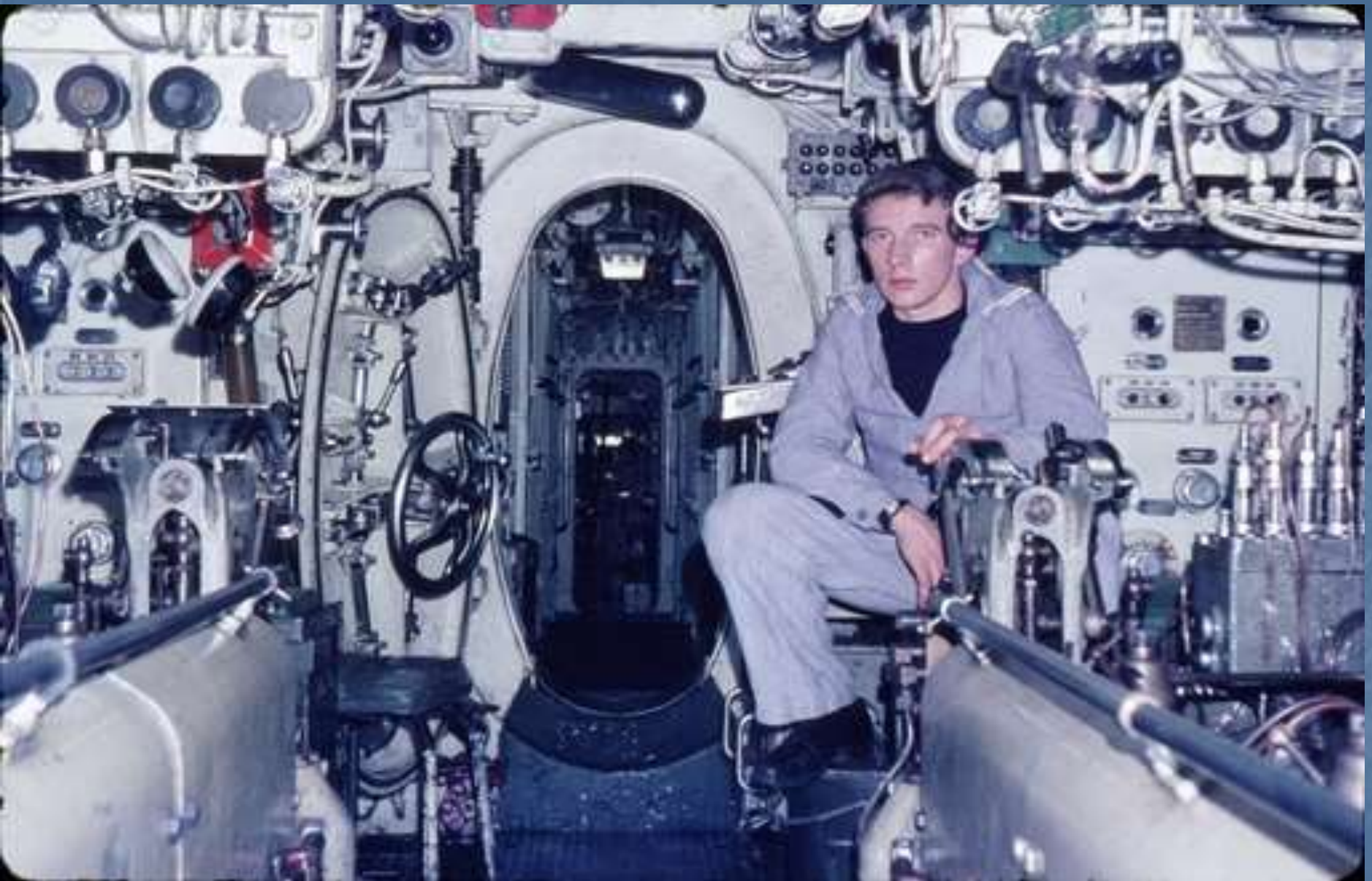
Poste de diéséliste bâbord et tribord, lancement des moteurs à l'air HP couplage avec les moteurs électriques pour le rechargement des batteries.
